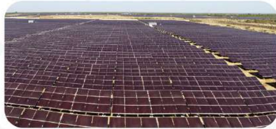
25 MW Jaisalmer RAJSTHAN (P.P.A. solar)
